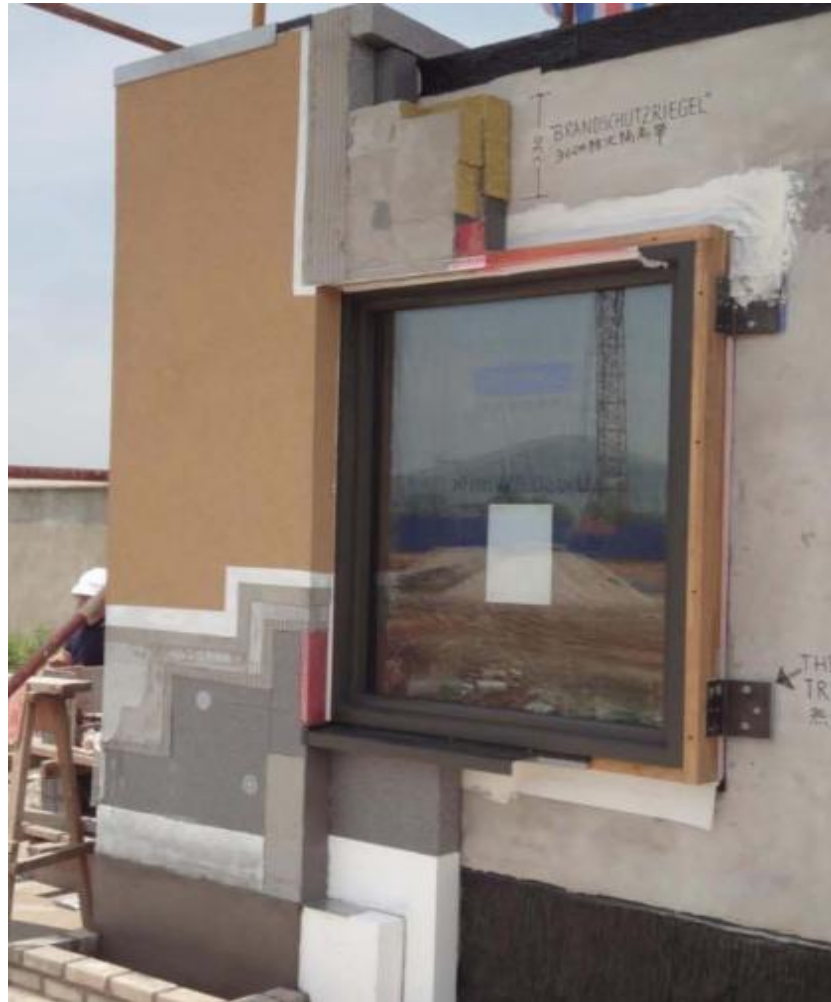
窗户安装完成
