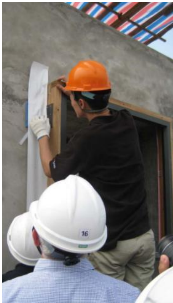
密封带b:透气防水（白色）粘贴于窗框外侧，实现气密性
