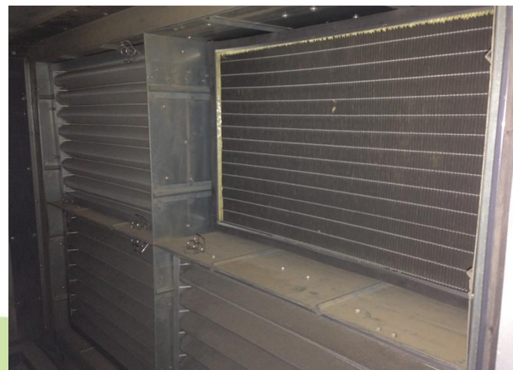
MZPAN-F9系列 2"板式高中效过滤器 金属边框， 化纤/玻纤 滤纸
